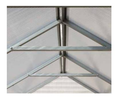
**Теплица «Министар» от компании «Воля»** сделана в форме домика из оцинкованной трубы 20х20, которая не поддаётся коррозии долгое время. За счет двускатной крыши в теплице домиком из поликарбоната больше полезного объема, так как растения могут располагаться возле боковой стенки.
